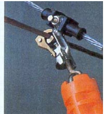
Colocação do gancho da vara na posição de "cardan" e aperto do ligador (mantendo a vara em ligeira tracção).
