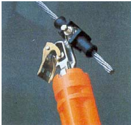
Introdução e recolhimento completo do gancho da vara no anel do parafuso do ligador.
