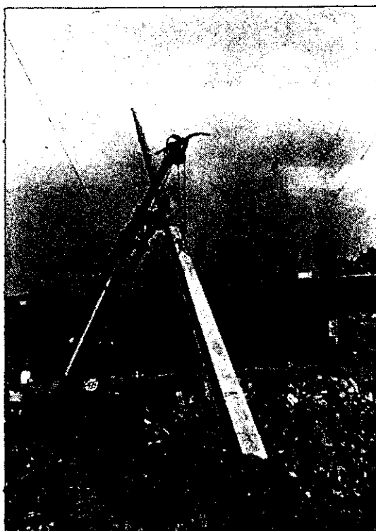
Levantamento do novo apoio por entre os condutores afastados
