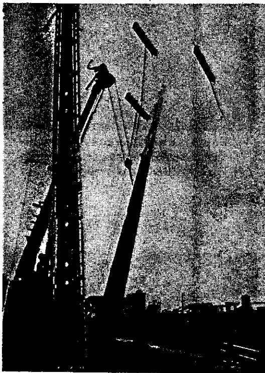
Apeamento do apoio substituído sendo a trajectória acompanhada pela protecção deslizante de condutores
